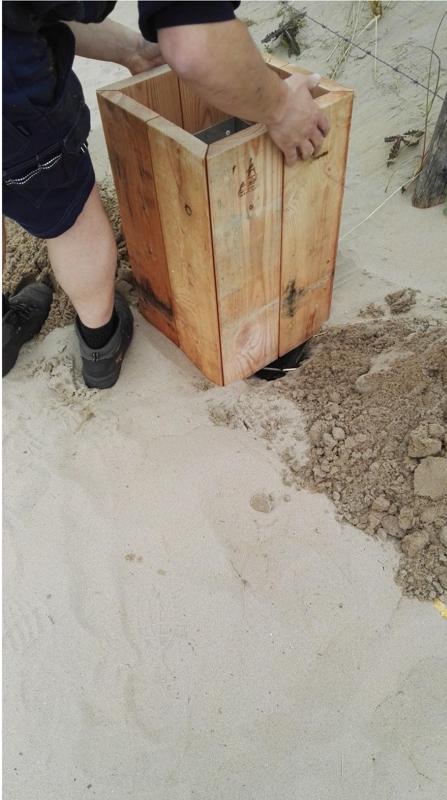
Afbeelding IV.4. Het ingraven van de verankering en het plaatsen van de buitenasbak.
