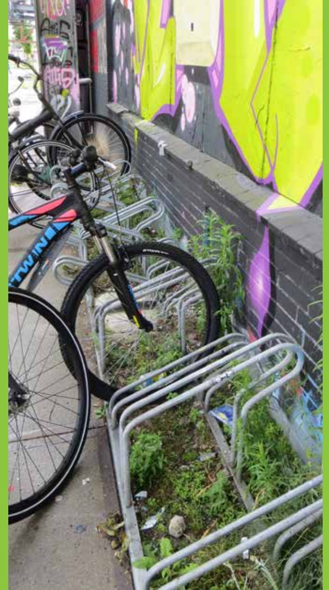
[151] Dit type fietsenrek houdt veel vuil vast en vergt een grote inspanning om schoon te maken.
