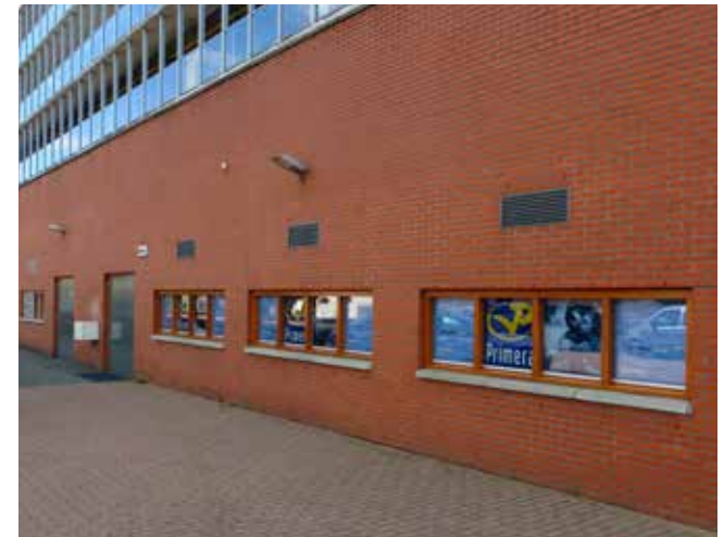
[34] Voorbeeld hoe een grote blinde muur kan worden teruggebracht tot menselijke proporties. De functieloze raampjes zitten op de goede hoogte, hebben een prettige afmeting en de 'vensterbanken' eronder maken het af.
