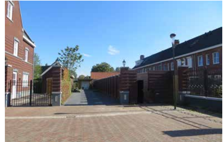
[51] In de basis is dit een vorm van een anonieme plek naar een garage. Door de twee kolommen aan de zijkanten straalt het uit dat je privégebied betreedt.
