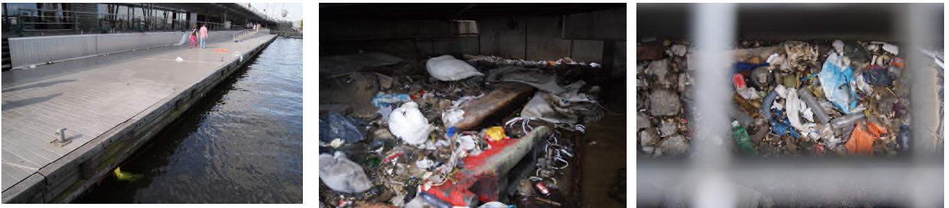
Figuur 2. Steigerconstructie Zouthaven in Amsterdam, met daaronder een grote hoeveelheid (drijf-)afval.
