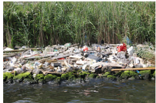
Figuur 3. Vervuilde stortsteenoever Noordzeekanaal.
