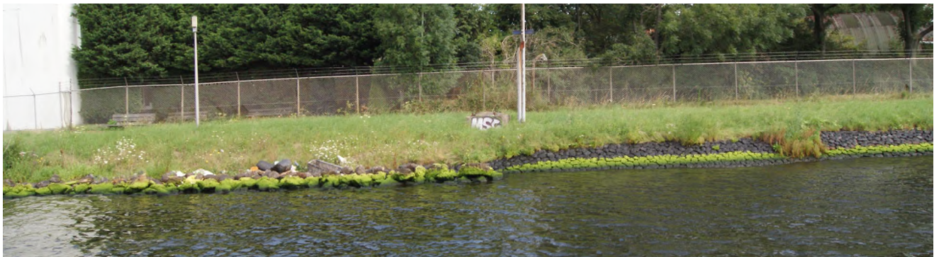
Figuur 4. Verschil tussen basaltsteenzetting (rechts) zonder afval en stortsteenoever (links) met duidelijk enkele grove afvalfracties.
