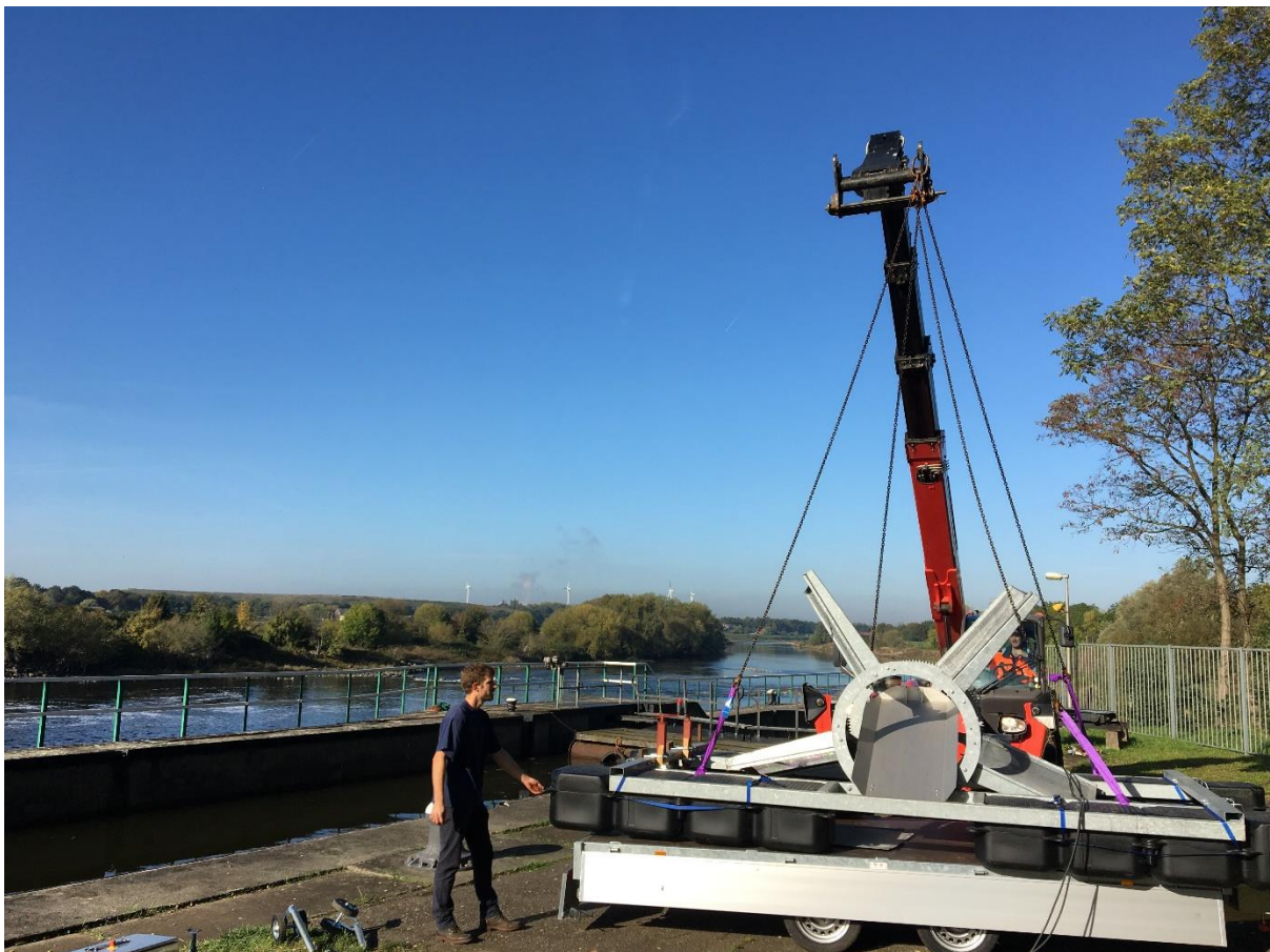
Figuur 3-3 Systeem wordt met verreiker van de aanhanger gehaald om hem vervolgens in de sluis te laten zakken
