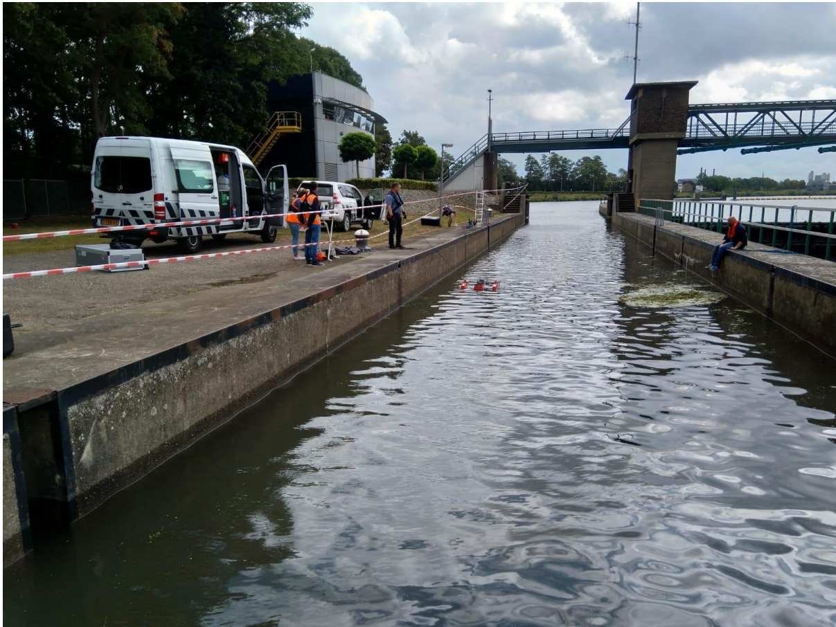
Figuur 3-5 Stabiele situatie met sluisdeuren bovenstrooms volledig geopend en laminaire stroming die wordt veroorzaakt door woelkelder benedenstrooms te openen
